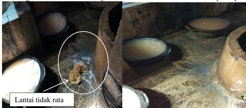
Gambar 2. Kondisi lantai yang tidak rata sebelum (kiri) dan lantai rata sesudah penerapan (kanan)
